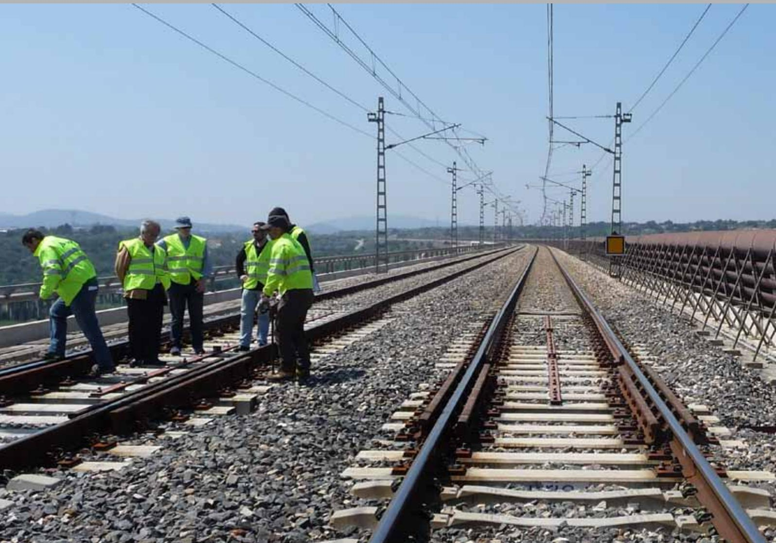
Los aparatos de dilatación fabricados en Amurrio están destinados a proteger las tensiones excesivas de la vía de barra larga a una vía de barra corta o a un aparato de vía (desvío, travesía etc...) no soldado a la barra larga, a puentes metálicos sin balasto o a puentes híper estáticos con balasto.
